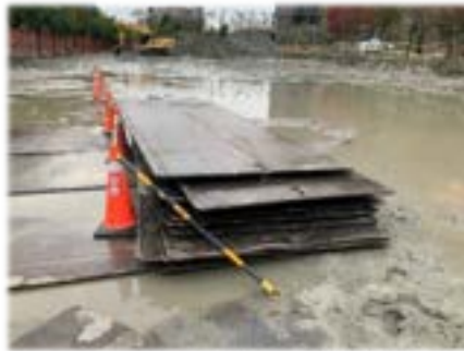
圖-工地設置防塵鐵板
