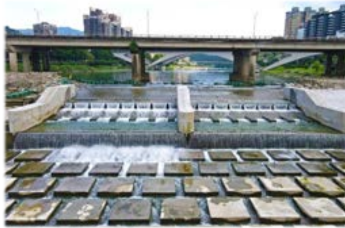
圖-碧潭堰局部
