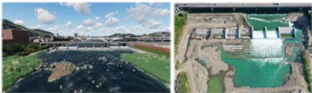
圖-碧潭堰外觀及施工現場空拍
