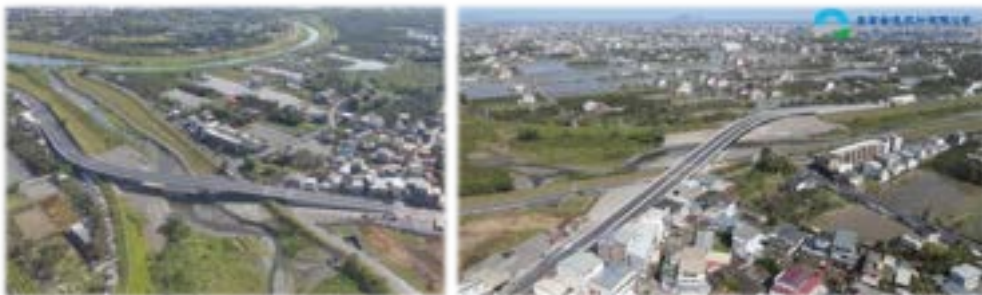
圖-新城橋改建工程
