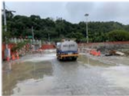
圖-高壓水車在工地灑水防塵
