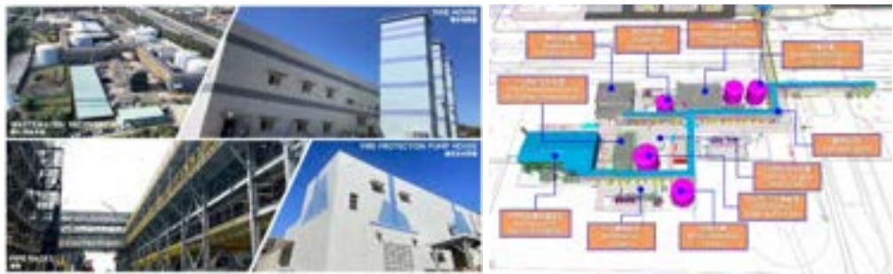
大潭電廠燃氣機組-BOP 土建工程（在建）
