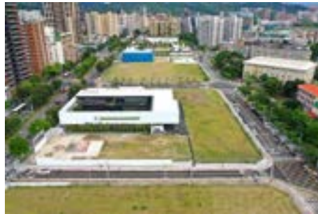
北投士林科技園區工程
