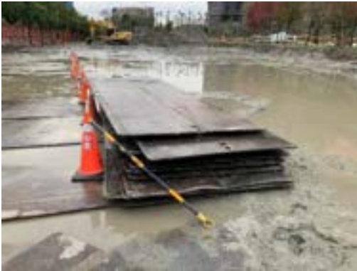
▲ 圖 1：工地設置防塵鐵板
