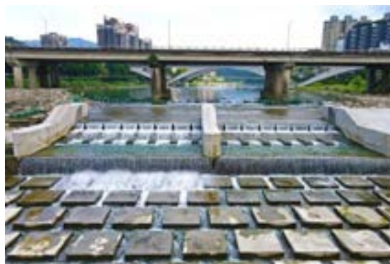
▲ 圖 3：碧潭堰局部
