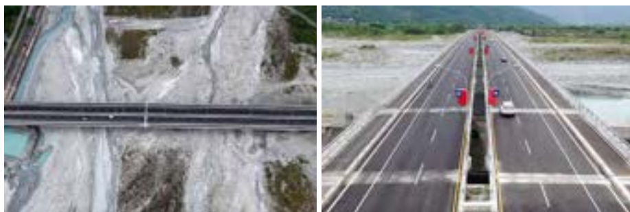
台 9 線馬太鞍溪橋改建工程
