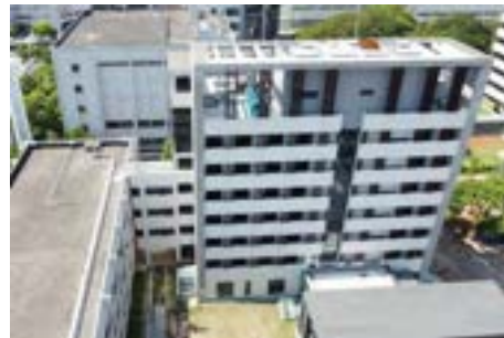
台電林口核能訓練中心宿舍大樓新建工程
