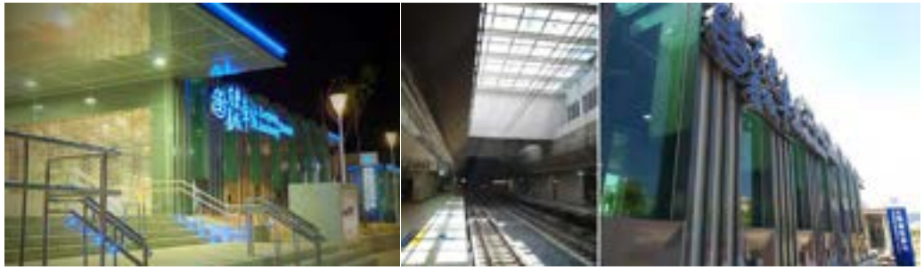
左營內惟車站及隧道接續工程
