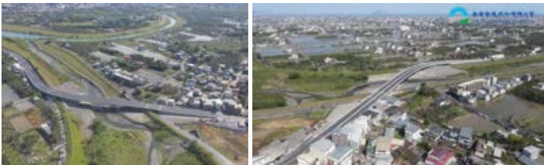
▲圖：新城橋改建工程
