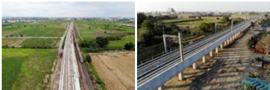
溫厝廂溪橋改建工程（在建）
