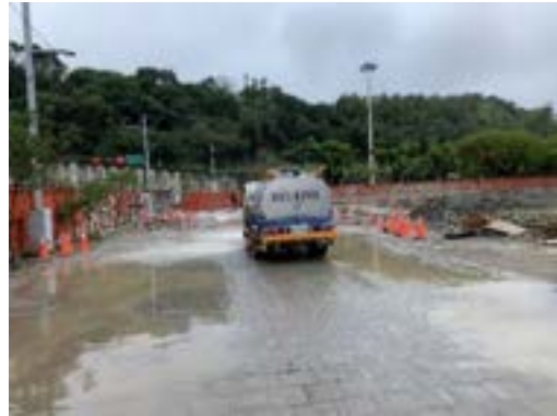
▲ 圖 2：高壓水車在工地灑水防塵
